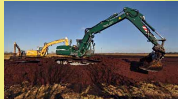
▲ Bagger beim Aufsetzen der Verwallungen
