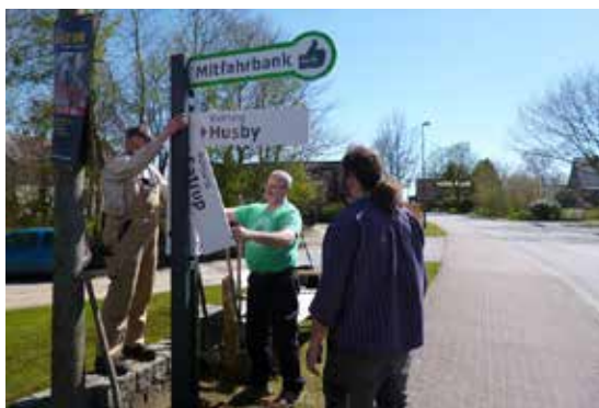
Bau der Mitfahrbank in Hürup. Quelle: Boben Op
